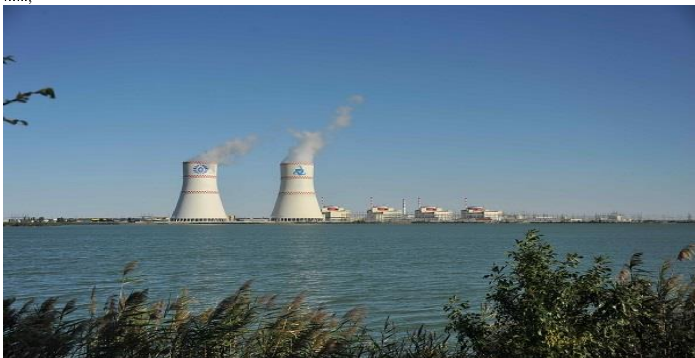
Фото 3. Зона наблюдения АЭС
