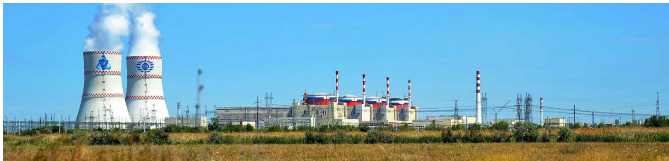
Фото 2. Общий вид Ростовской АЭС.
