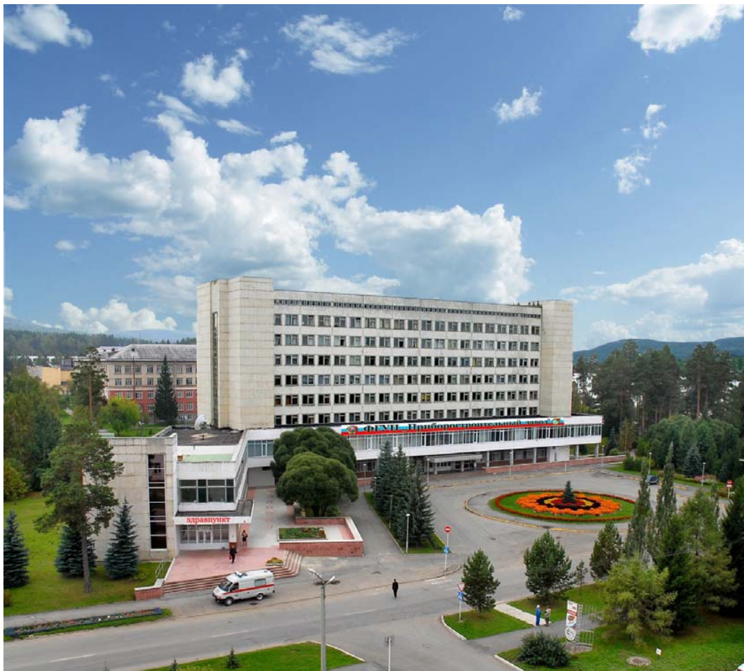
Федеральное государственное унитарное предприятие «Приборостроительный завод»
