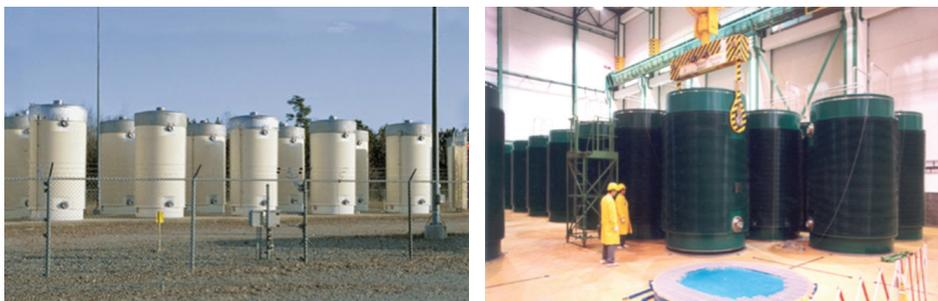
Рис. 17.4. Примеры хранилищ ОЯТ с использованием двухцелевых контейнеров
